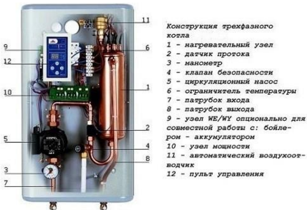
Рисунок 2 – Конструкция трехфазного электродного котла [1]
