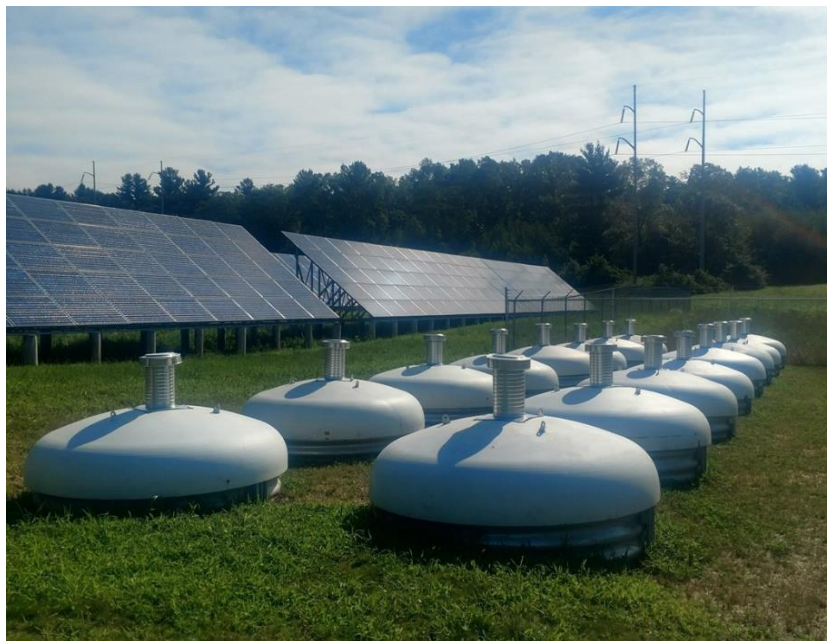
Рисунок 3 - Солнечная электростанция, использующая маховик
