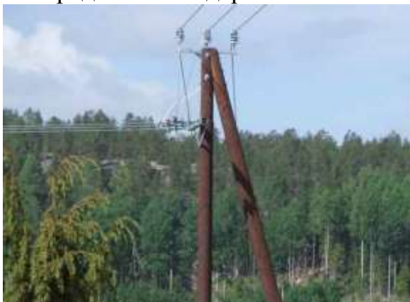
Рисунок 1. Деревянная опора ВЛ-10 кВ
