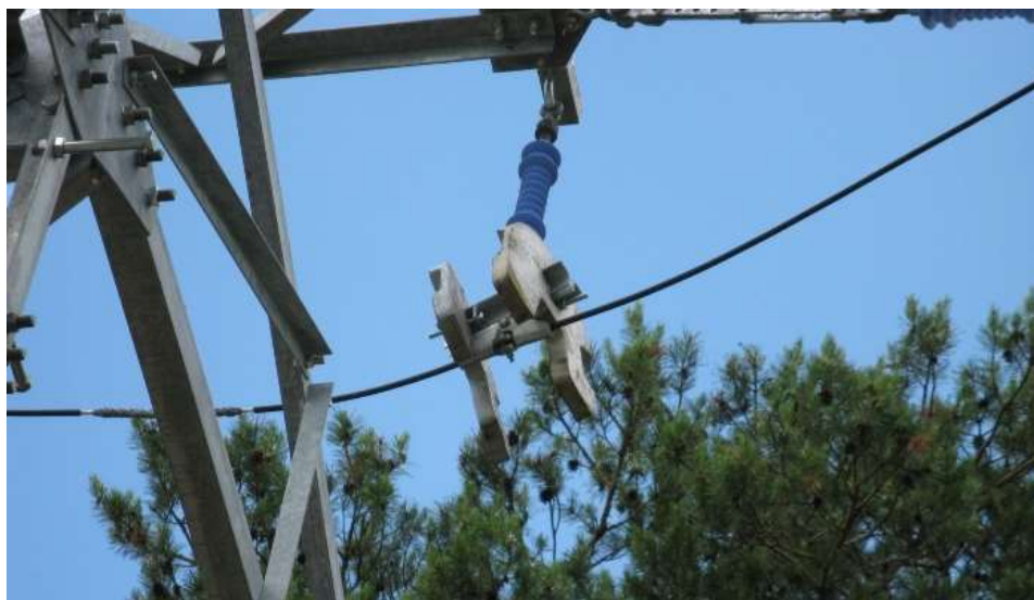
Рисунок 4. Крепление провода
