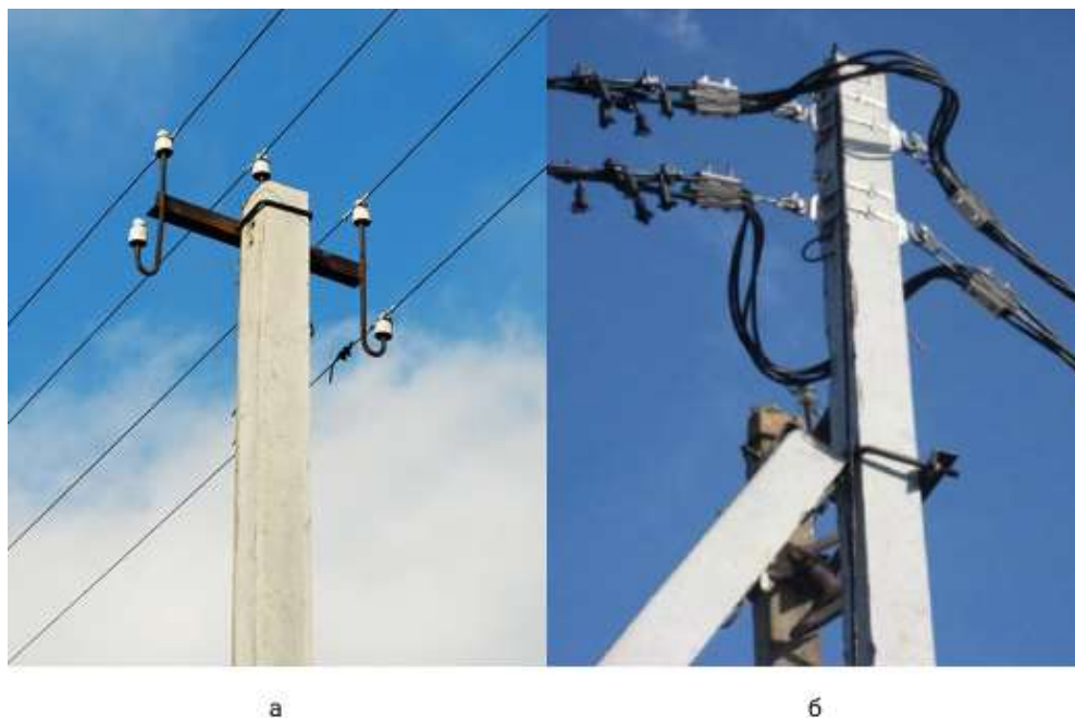
Рисунок 5 – Сравнение конструктивных особенностей ВЛИ и ВЛ: а – ВЛИ; б – ВЛ
