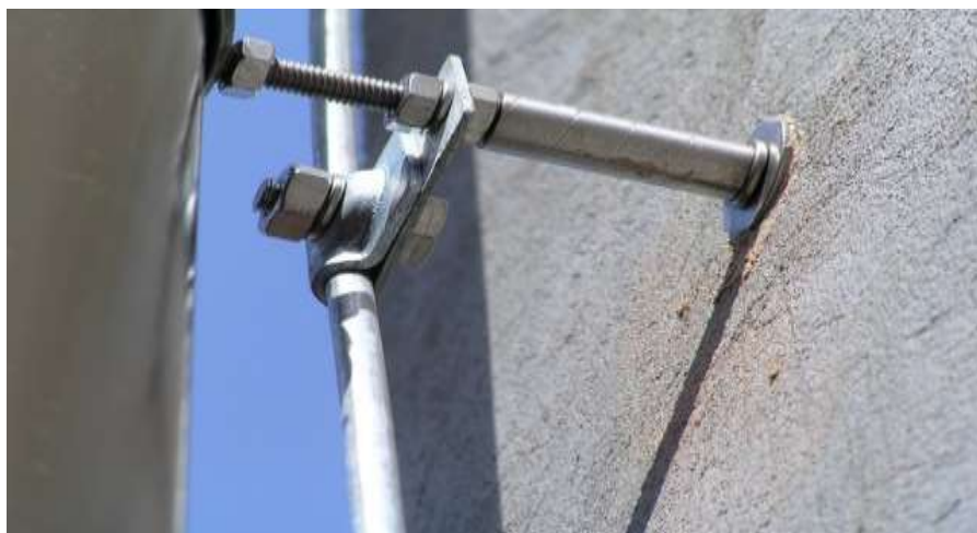
Рисунок 3. Соединение токоотвода с заземлителем
