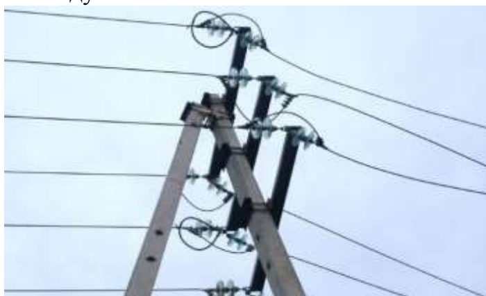
Рисунок 4. Разрядники на ВЛ 10 кВ
