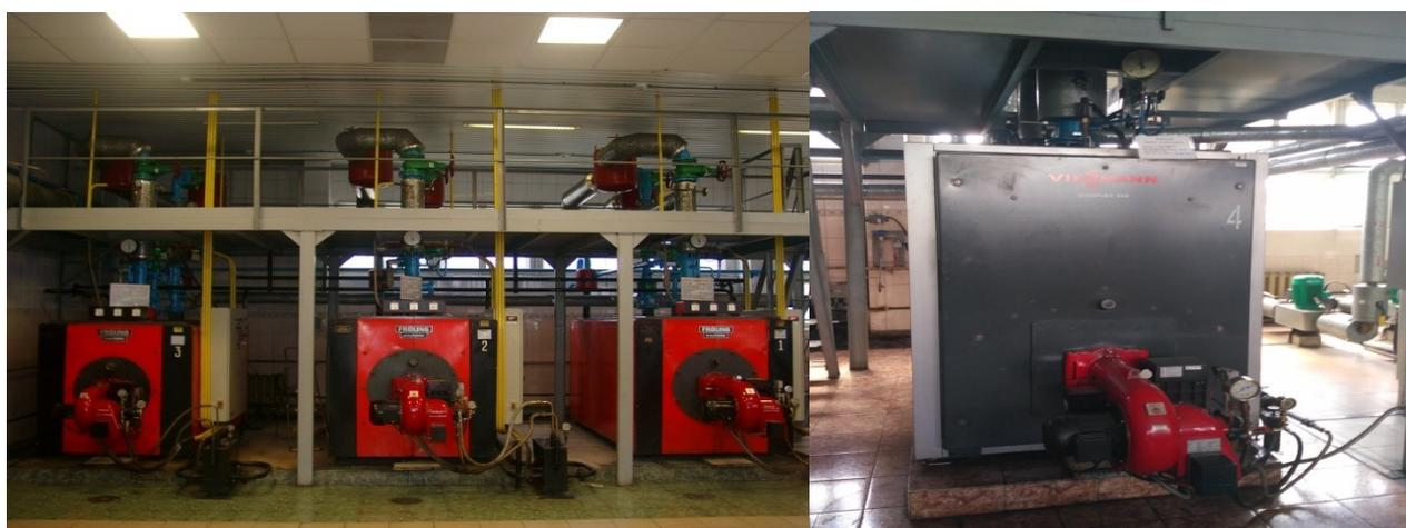
Рисунок 1 - Котлы, установленные на котельной вместе с горелками
