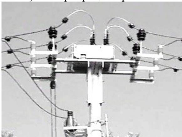
Рисунок 1 – Высоковольтный модуль реклоузера РВА/TEL "Таврида Электрик"
