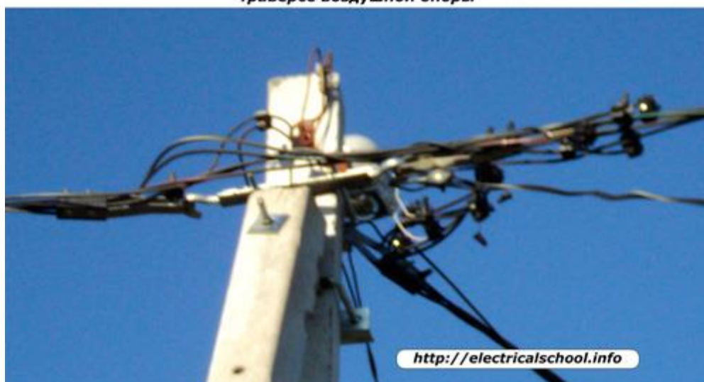
Рисунок 4. Крепление самонесущих изолированных проводов ВЛ-0.4 кВ
