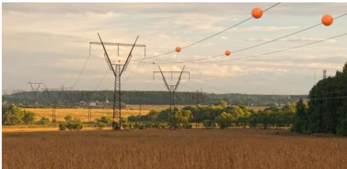
Рисунок 4. Маркеры для воздушных линий электропередачи
