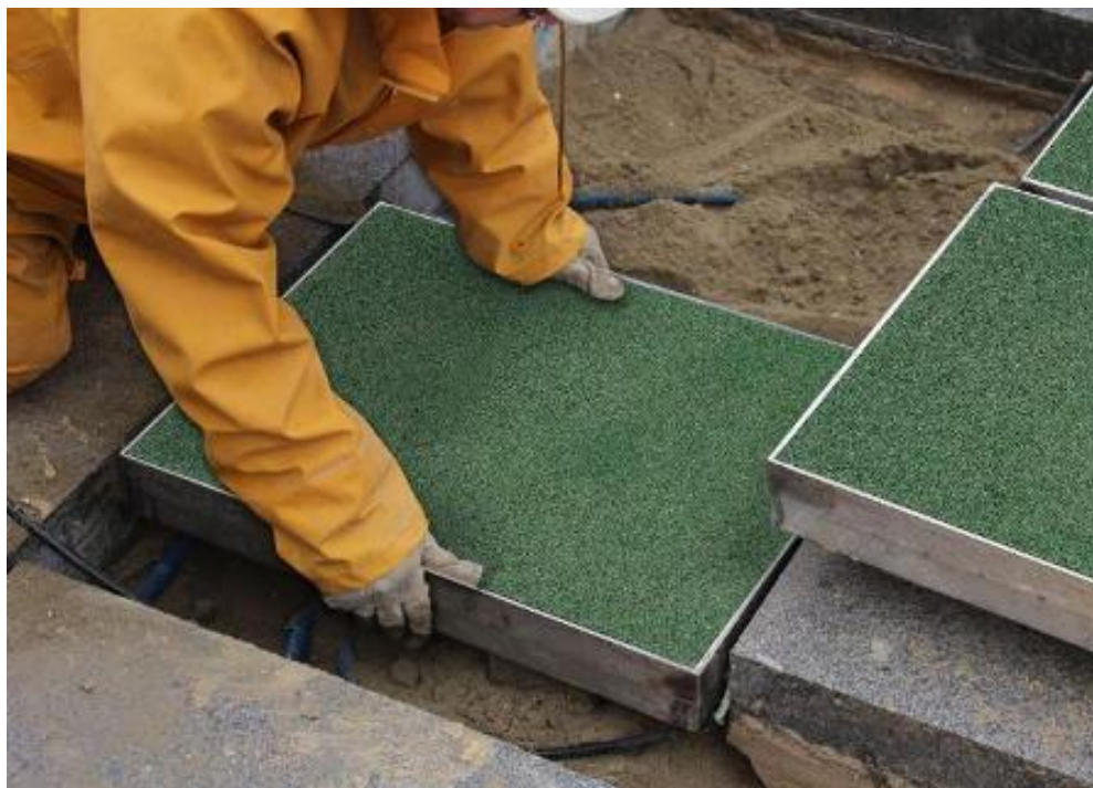
Рисунок 3. Процесс установки тротуарной плитки, генерирующей электроэнергию
