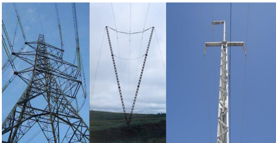
Рисунок 5. Металлические опоры воздушных линий
