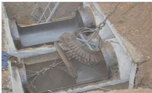
Рисунок 1 – Прочистка трубы механическим способом
