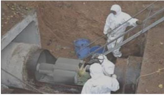
Рисунок 2 – Нанесение цементно-песчаного покрытия электрической металлической головкой
